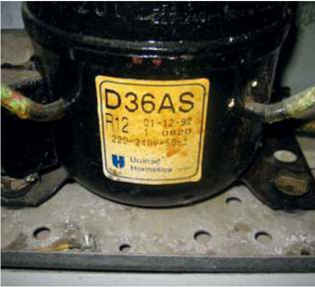
Kompressor, welcher das verbotene FCKW R12 (Dichlorodifluormethan, Freon 12) enthält - gefährlicher Abfall Compressor containing the prohibited CFC R12 (dichlorodifluoromethane, Freon 12) - hazardous waste (Photo: KLIF)
