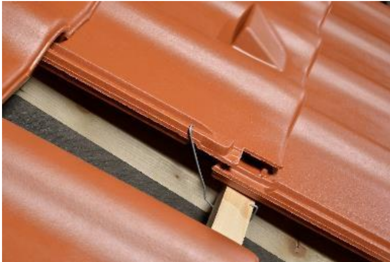
Abb. 12: Seitenfalz-Einhängeklammer zum Einhängen bei der Dachlatte
