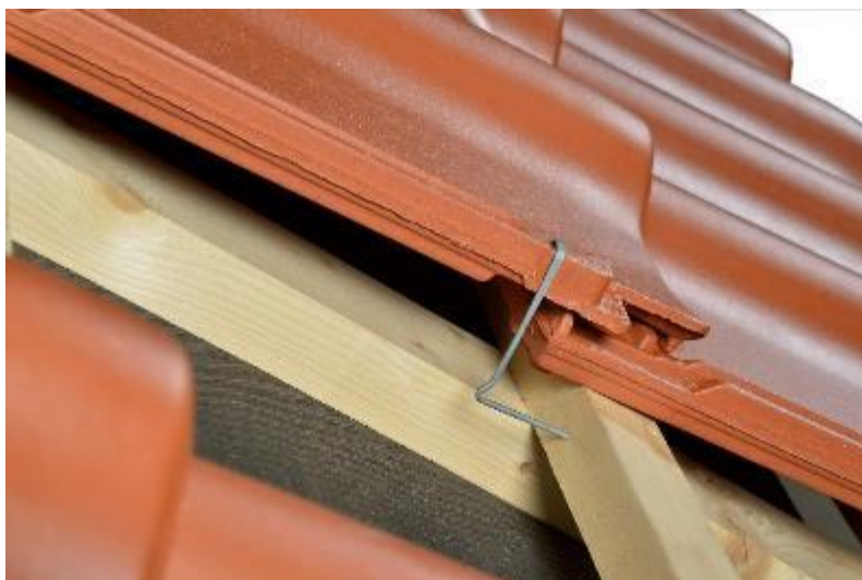
Abb. 11: Seitenfalz-Einschlagklammer zum Einschlagen in die Dachlatte
