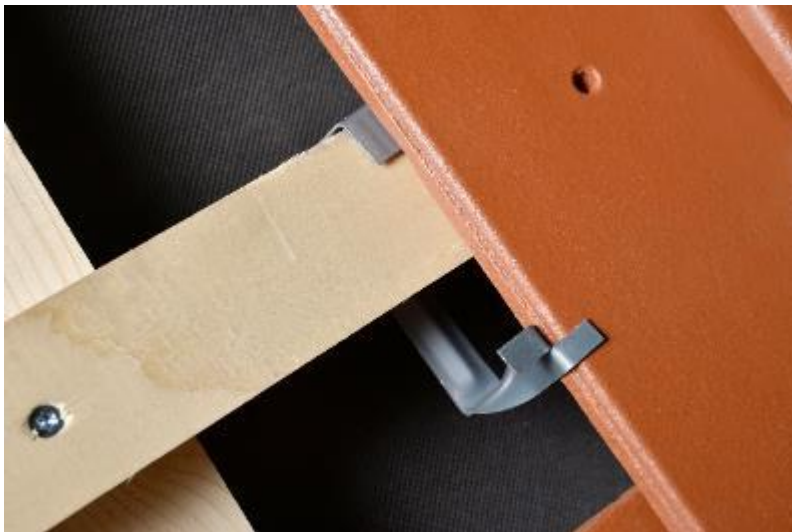
Abb. 13: Sturmklammer zum Einhängen bei der Dachlatte (für Biber-/Taschenziegel)
