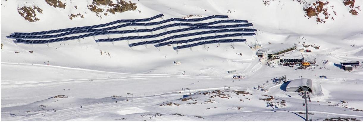
Europas **höchstgelegenes Photovoltaik-Kraftwerk** steht auf fast 3.000 m am **Pitztaler Gletscher**. Die jährliche Produktion liegt bei rund 1.450.000 kWh/Jahr und deckt nicht nur einen großen Teil des Energiebedarfs des Unternehmens ab, sondern erzeugt diesen Strom aus erneuerbarer Energie und mit höchstmöglicher Effizienz.
