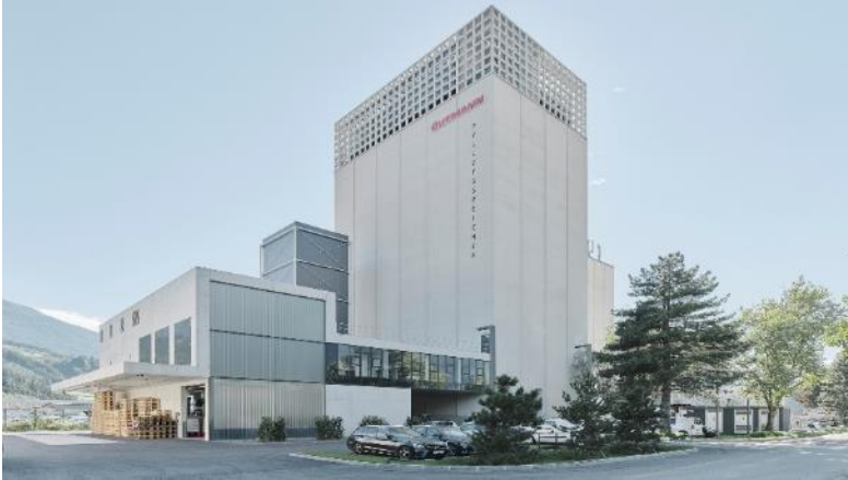
Gutmann Pelletsspeicher Hall in Tirol
