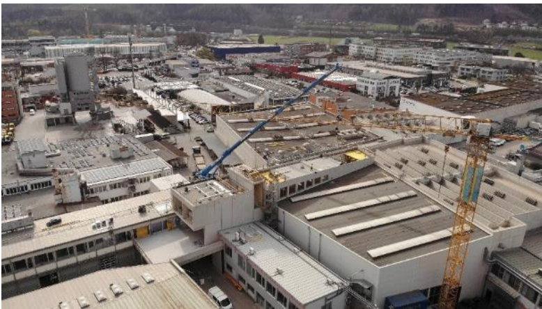
Metallwerk F. Deutsch Blockheizkraftwerk in Innsbruck
