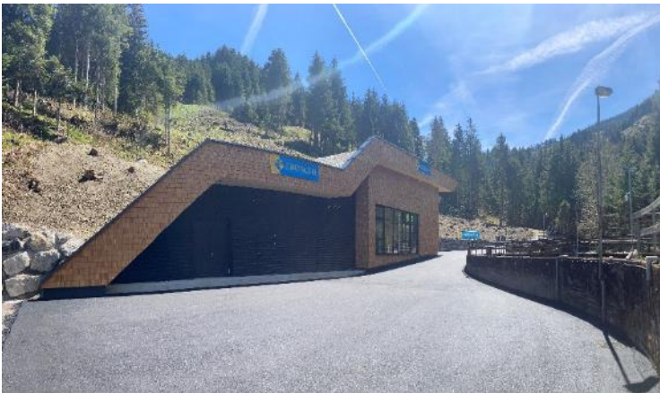
Gemeinschaftskraftwerk Weerbach am Weerberg
