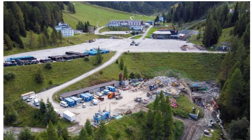
Bereich Wasserfassung - rechts im Bild: Schalarbeiten für das Entsanderbauwerk und die temporäre Bachverrohrung
