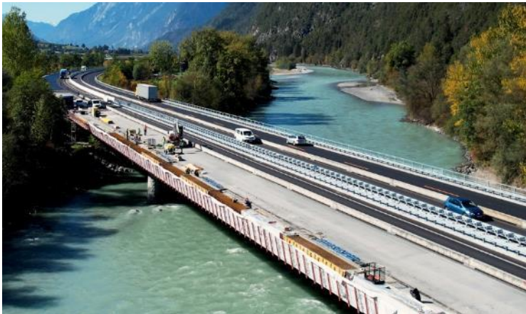
A12 Inntal Autobahn Telfs West bis Rietz
