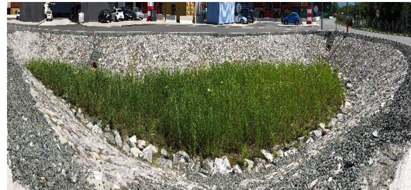
Fertiggestelltes Vererdungsbecken ÖBB CCT WOLFURT, 2018
