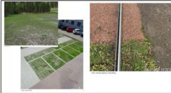
Versickerungsfähiger Bodenbelag für Parkplätze, Lagerflächen und Zufahrten (Feuerwehr Zufahrt geeignet !)
