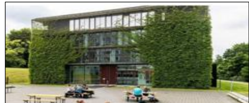
Grüne Wand zur baulichen Abgrenzung und/oder Absorption von Lärm und Staub.
