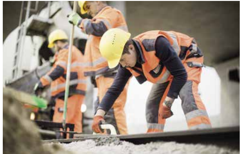
Auch in Zeiten der Pandemie war Hochbetrieb auf den Baustellen.
