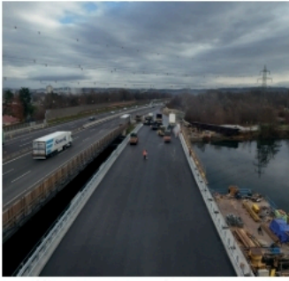
Wegen Arbeiten an der neuen Murbrücke wird gesperrt. ASFINAG
