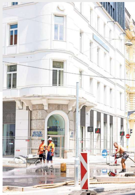
Die aktuelle Baustelle am Joanneumring, eine von vielen in der Innenstadt
