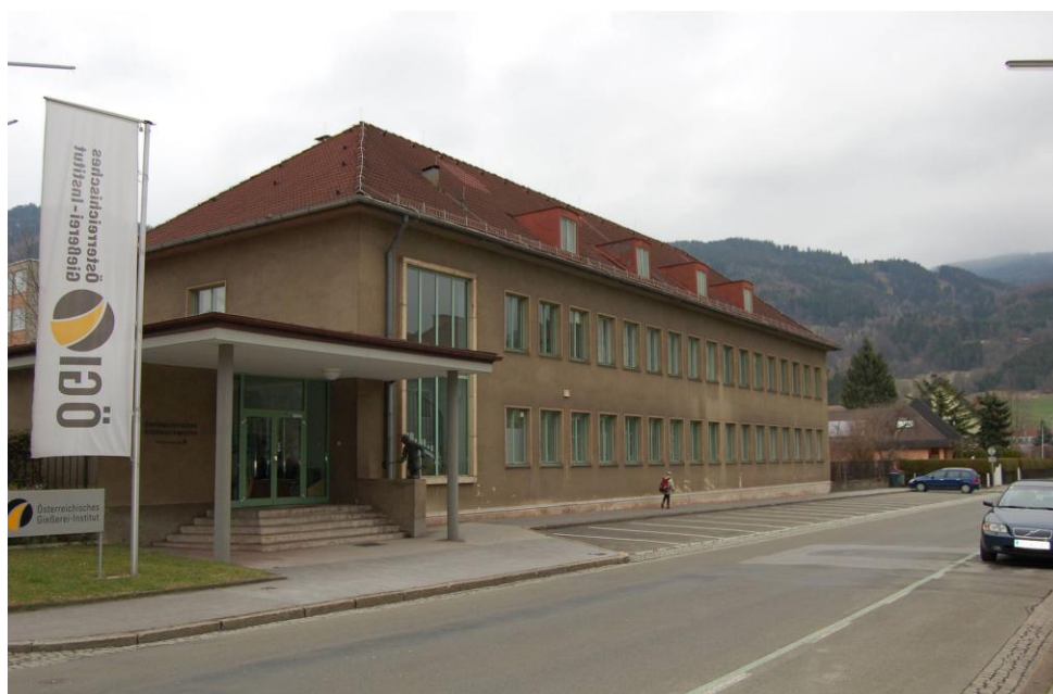
Bild 12: Außenansicht des ÖGI vor der thermischen Sanierung
