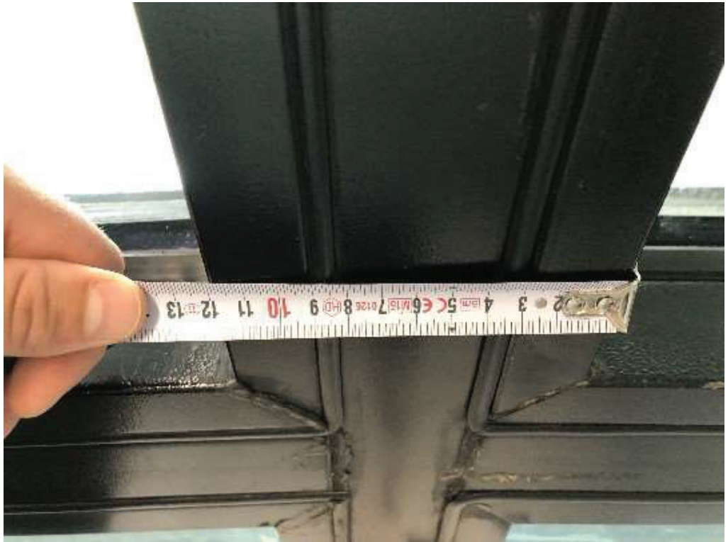
Bild3_Profilbreiten Bestand
