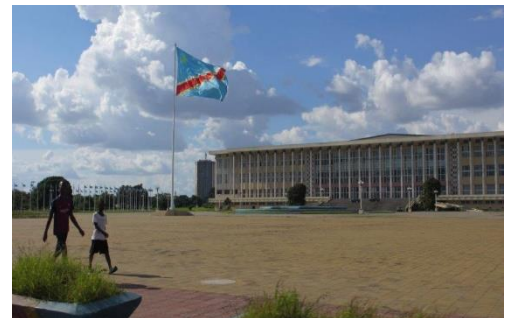
Palast des Volkes, Kinshasa ©AußenwirtschaftsCenter Lagos
