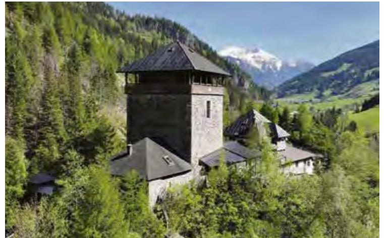
Die Burg Klammstein gilt als ältestes Bauwerk im Gasteinertal, von hier aus wurde das Tal besiedelt.
