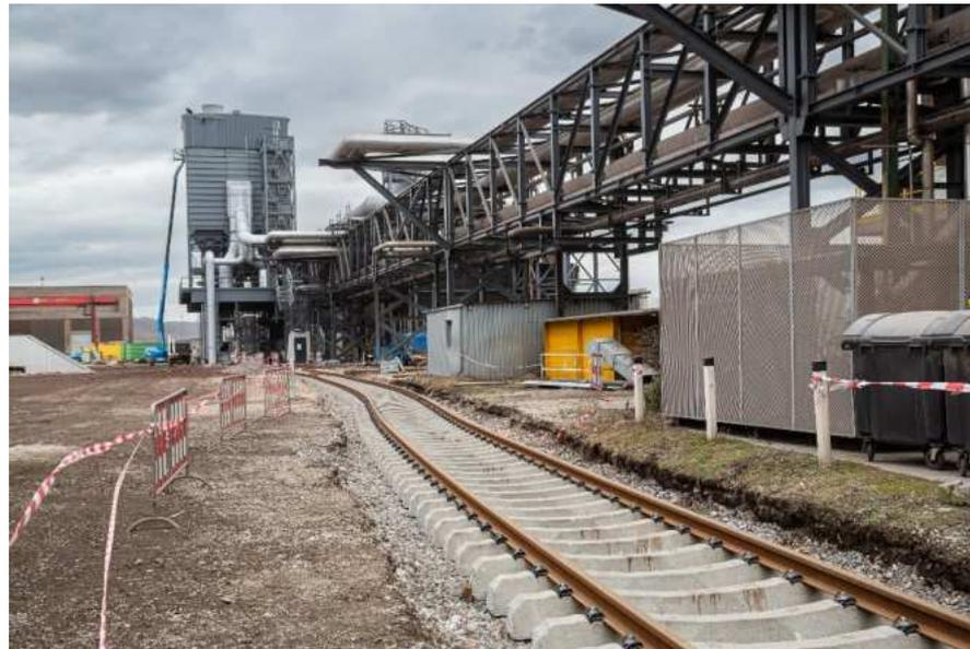
» Förderbandbrücken errichtet, Kalkentladung mit Entstaubung und Versorgungsgleis
