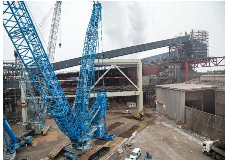
» Montage des letzten Segments der Förderbandbrücke; Österr. größter Mobilkran und die fertige Förderbandbrücke 2
