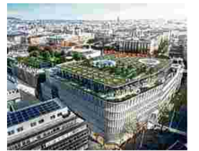
Shoppin mit Dachgarten Foto: apa
