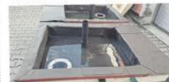
Eine EPDM-Abdichtung auf einem Modell mussten die Spengler und die Dachdecker fertigen.
