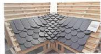
Zu den praktischen Arbeiten der Dachdecker zählte eine deutsch-eingebundene Ziegelkehle.
