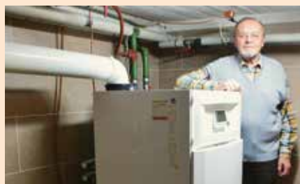
Die Familie S. in Laakirchen kombiniert ein Öl-Brennwertgerät mit Brauchwasserpumpen.
