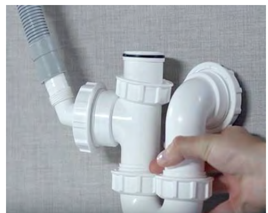
Richtiger Anschluss eines Ablaufschlauches an den Abfluss eines Waschbeckens.
