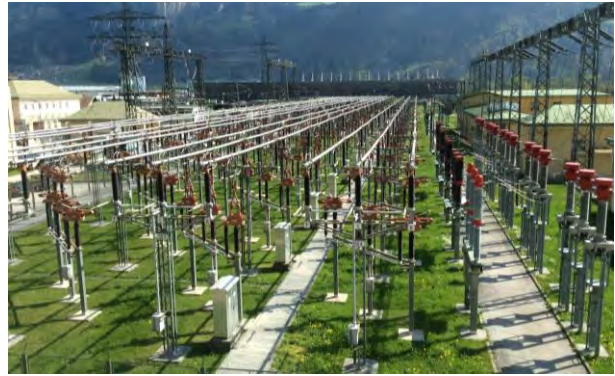
Umspannwerk, bei dem Strom auf Hochspannung zum Transport vorbereitet wird. Fotos: Mehnert
