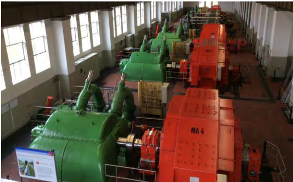
Generatoren eines Wasserkraftwerkes
