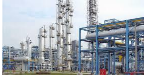
Maschinenbau und Industrieanlagen
