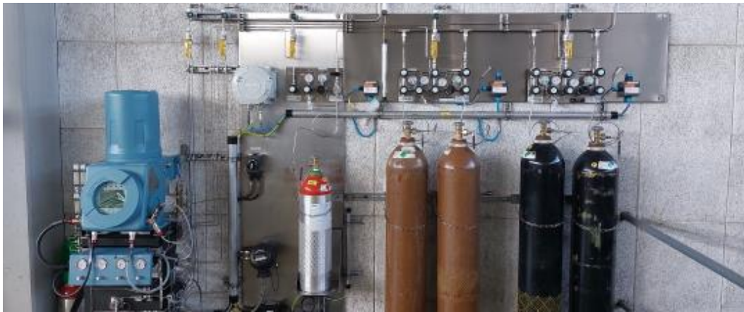
Gaschromatograph zur Analyse der Gasqualität
