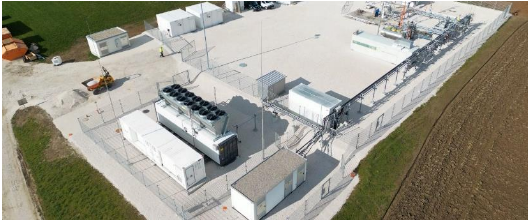
Underground sun storage 2030 - Elektrolyseanlage zur Erzeugung von Wasserstoff
