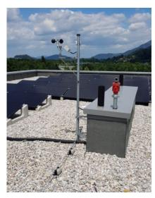
Fallbeispiel: Einbindung eines Windmessers in das bestehende Blitzschutzsystem gem. ÖVE/ÖNORM EN 62305-3:
