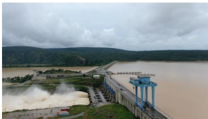
Wasserkraftwerk Jebba am Niger Fluss © Mainstream Energy Solutions Limited
