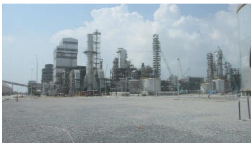
Dangote Düngemittelfabrik bei Lagos
