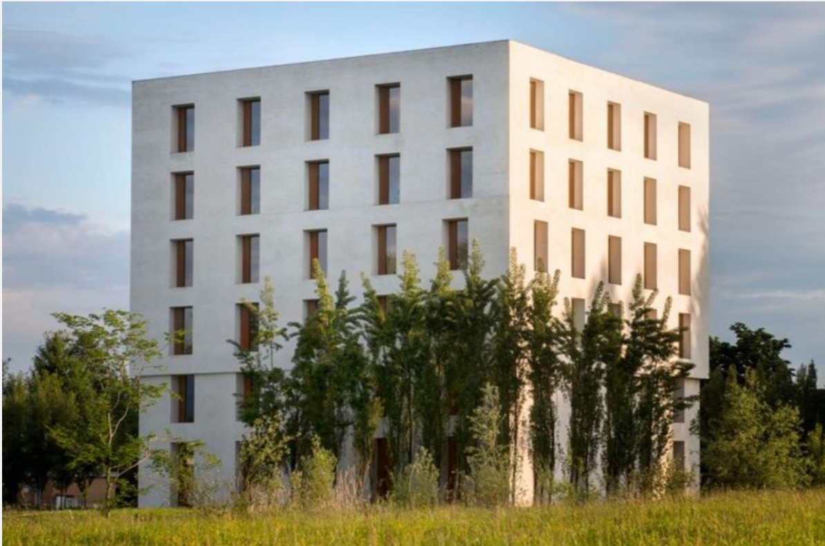
Abbildung 3 2226 Lustenau, Quelle: Baumschlager Eberle Architekten, 2022
