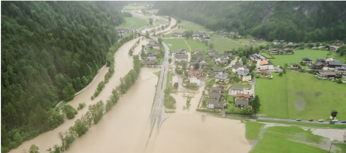
Foto: Hochwasser 2013, B311 - Pinzgauer Straße, Überflutung;
